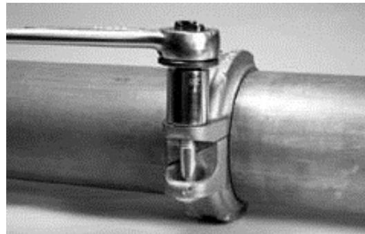
6. Вставьте оставшийся болт и наверните на него гайку, затянув ее вручную. ПРИМЕЧАНИЕ: Убедитесь, что овальные подголовки болтов надежно зафиксированы в болтовых отверстиях.
