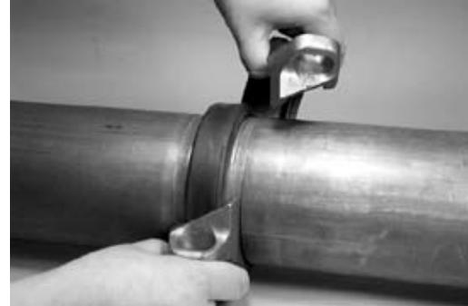
4. Совместите концы труб по одной линии и сведите их вместе. Сместите уплотнение в требуемое положение и удостоверьтесь в его расположении строго по центру между пазами на каждой трубе. Удостоверьтесь, что ни одна из частей уплотнения не попадает в паз любой из труб.
